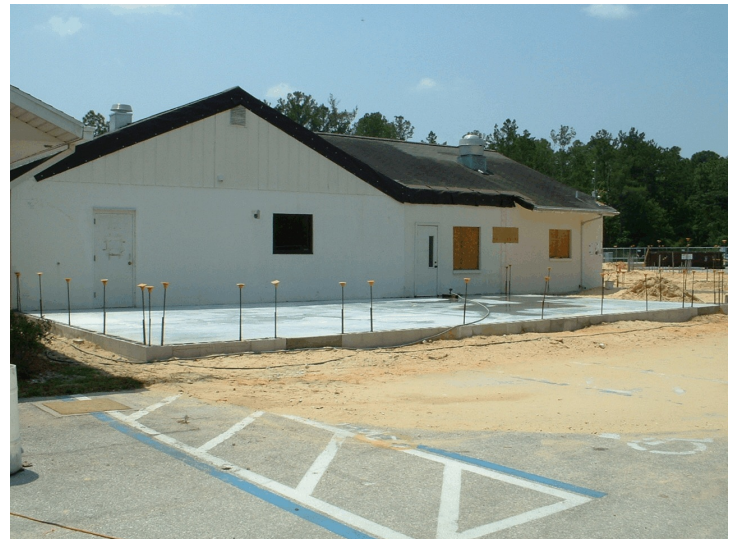
Thrift Shop pad after concrete pour
