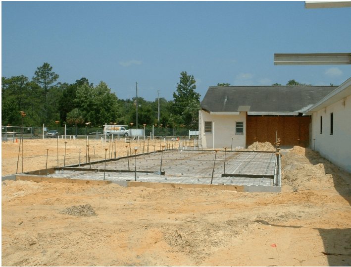
Youth Room pad ready for concrete pour
